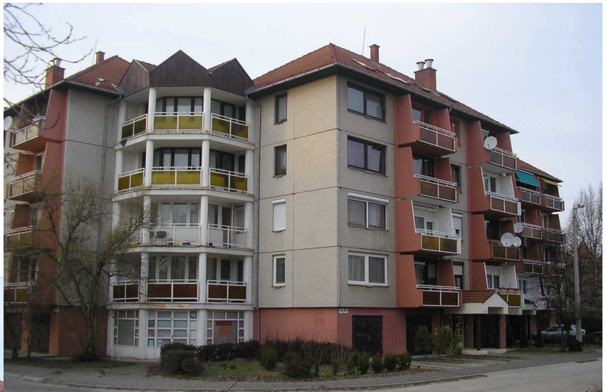
Magastetős tetőtérbeépítés, nyeregtető kontyolt tetővéggel
