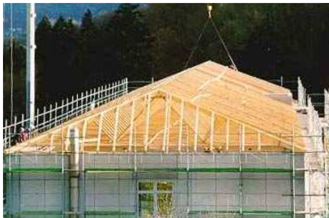
szeglemezes fa tetőszerkezet (fotó: Dettling AG)
