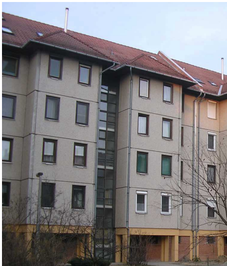
Nyeregtetős lefedés tetőtérbeépítéssel
